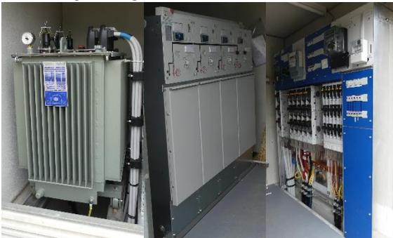
Bei der TS Langmatt wurde der bisherige 400 kVA Transformator mit einem 630 kVA Transformator ersetzt und die MS- und NS-Verteilung erneuert.
